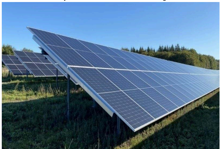
Figur 4: Eksempel på Fixed-tilt S opsætning.
