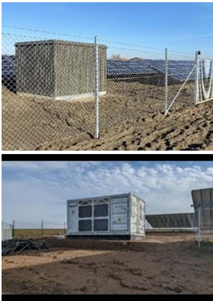
Figur 8. Eksempel på parktransformer.
